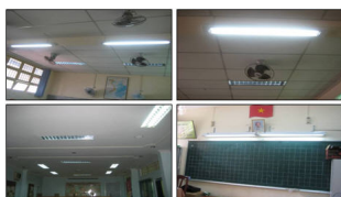
Đèn được bố trí hợp lý và được lắp chóa phản quang
